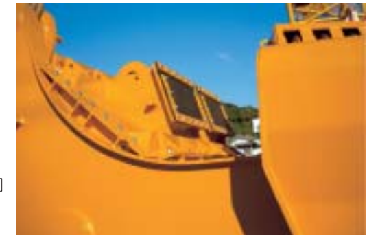
開閉式特殊ゴム板蓋(逆止弁)
